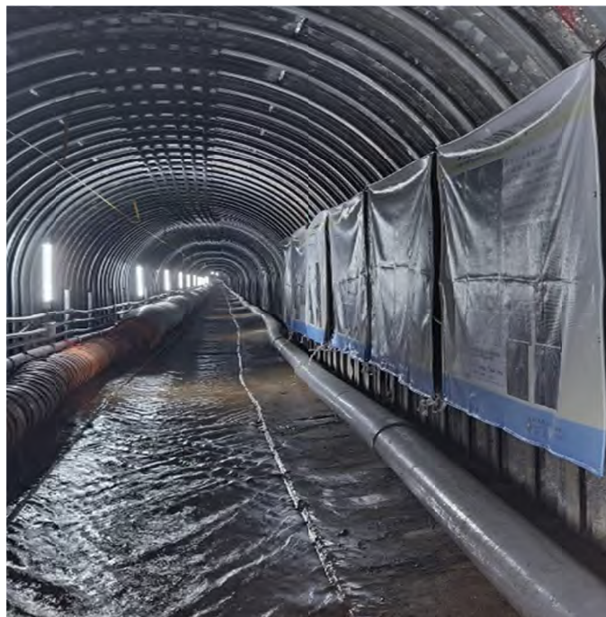
圖 3-31 G1 排水廊道檢修補強二期工程
