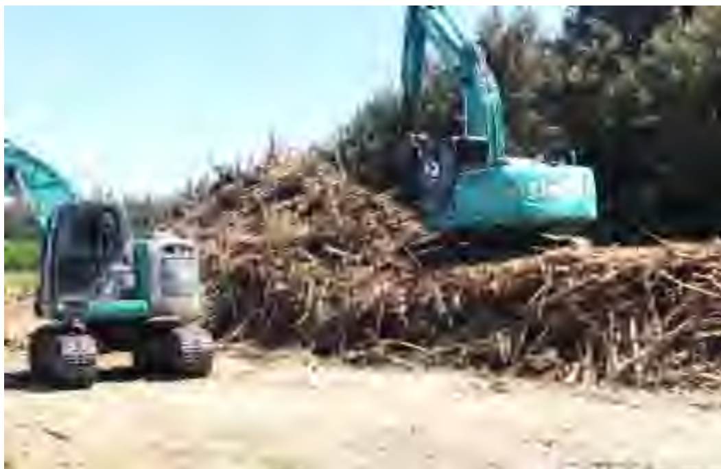
圖 9-9 臺南市政府委託廠商清運竹棚廢棄物
