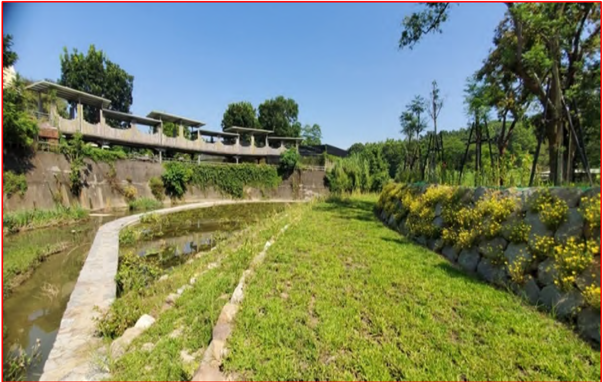
圖 3-27 111 年度第 22 屆公共工程金質獎優等「虎源溪(新化林場段)整治二期」
