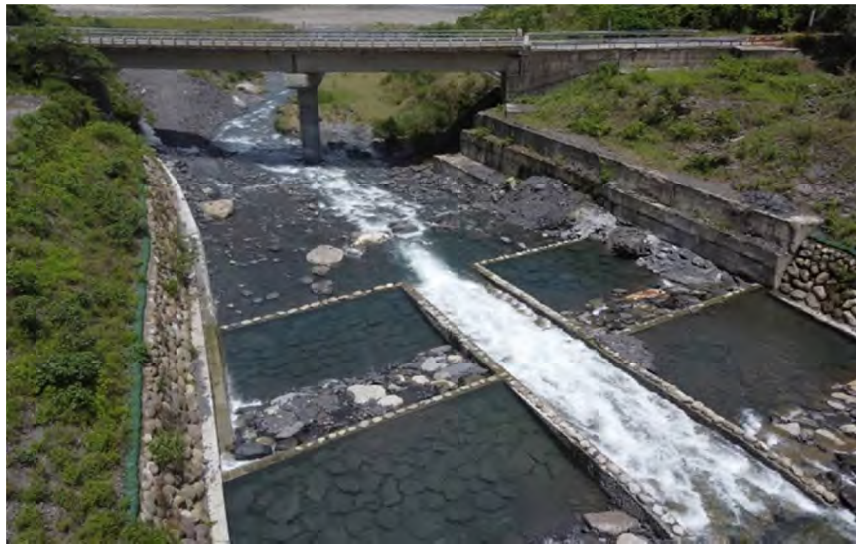
圖 3-24 坑溝土砂防治工程
