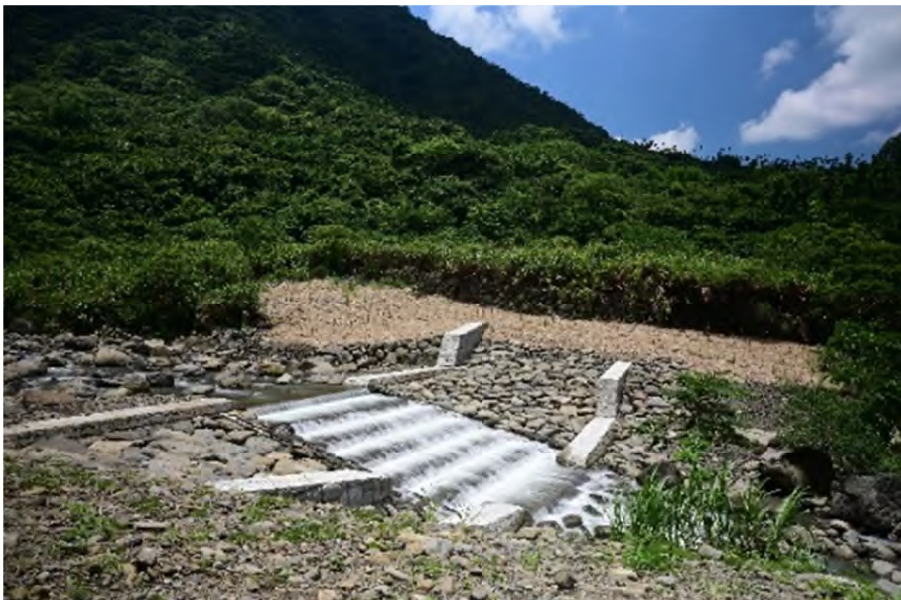
圖竹崎鄉金獅村及文峰村牛稠溪區域排水治理工程
