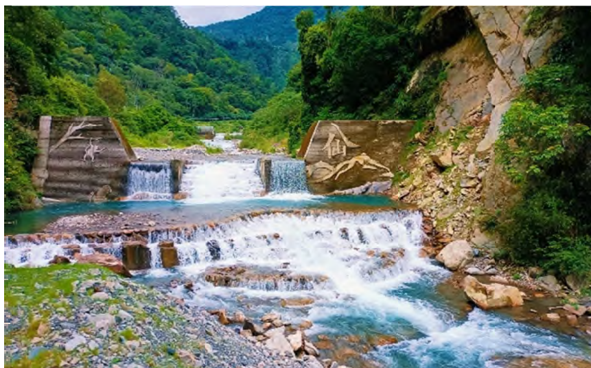
圖 3-23 十文溪下游治理工程
