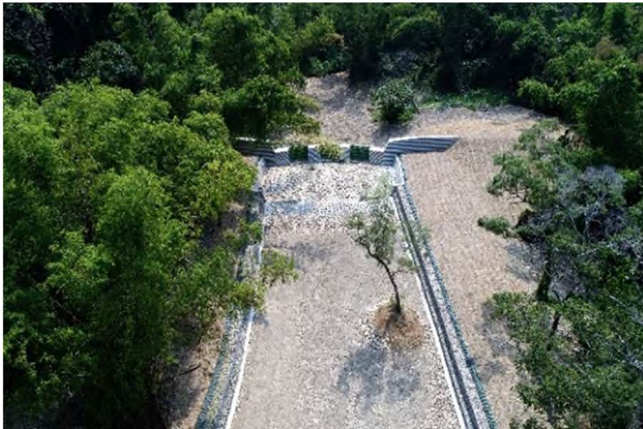
田中鎮 1704 保安林太平坑整治工程
