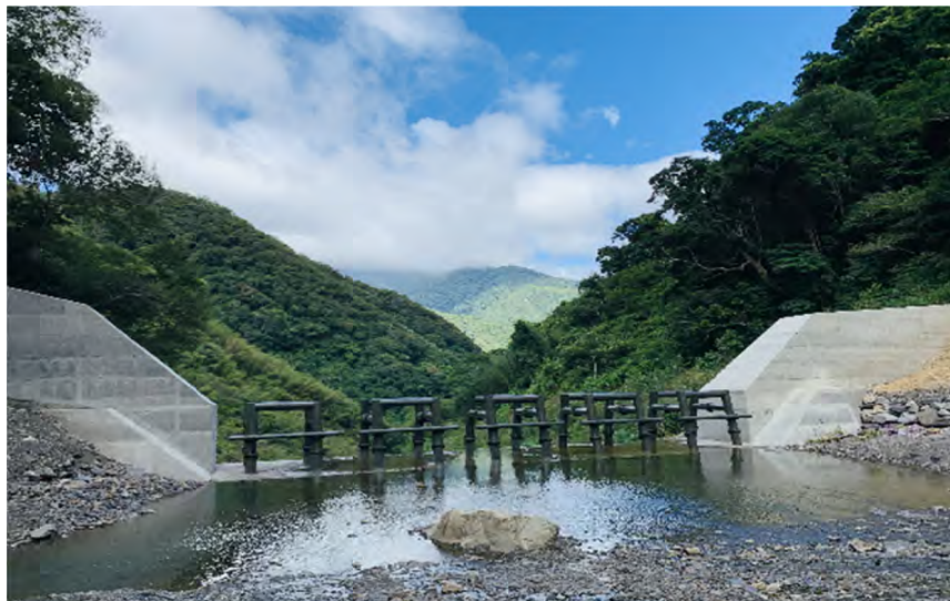
圖 3-25 蘇樂溪防砂設施改善工程
