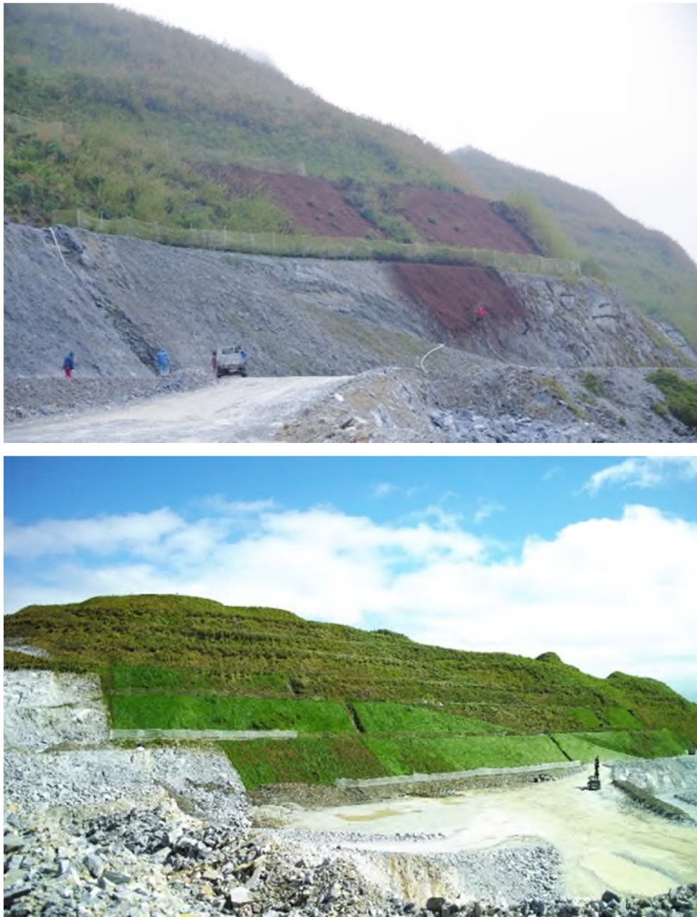
圖 8-25 礦場植生復育示意圖-台泥蘇澳廠太白山大理石礦場
