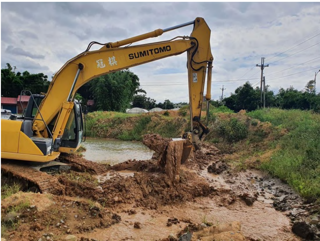
棄置農地怪手現場開挖情形
