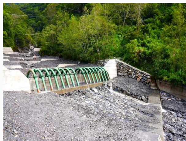
埔里區16林班坑溝第二期整治工程
