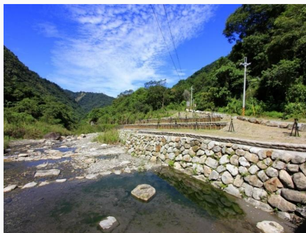
東卯溪防砂壩改善工程
