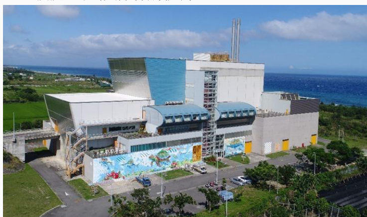
圖 11-11 臺東縣垃圾焚化廠已重新啟用運轉
