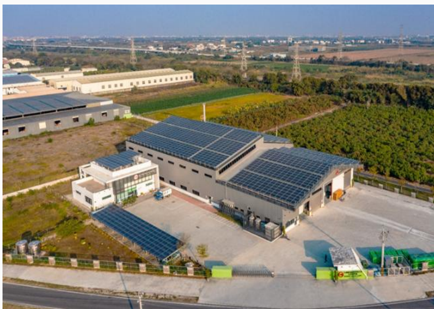
圖 11-14 輔導台糖建置生技材料廠推動廢棄牡蠣殼回收處理 （台糖提供全廠空拍圖）
