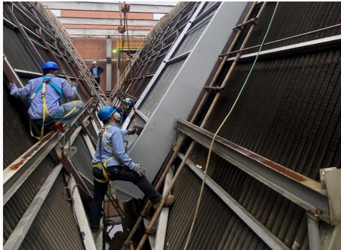
圖 11-9 氣冷式冷凝器散熱鰭片更新，提升發電效率（基隆市廠）
