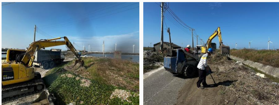
圖 9-44 清運養殖廢棄物施工照片
