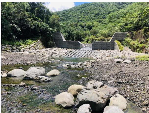
雙流溪壩體改善工程
