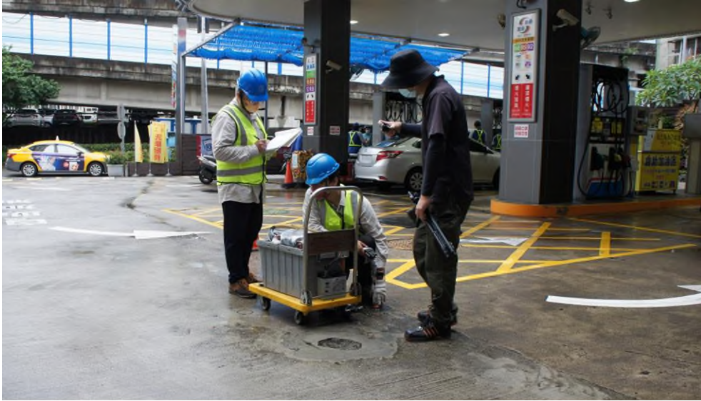
土壤氣體監測井現場檢測情形
