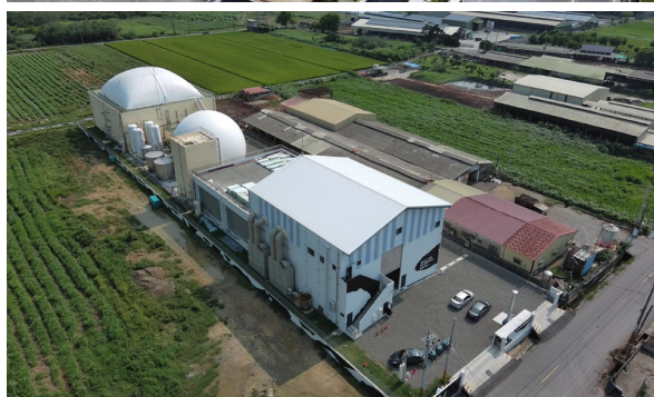
臺南市八翁里畜牧糞尿資源化處理中心，為臺南市首座畜牧糞尿集中處理設施
