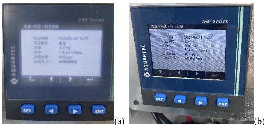
圖 14 固定式餘氯感測器現場校正數值：(a)忠孝站；(b)金山十八街站
