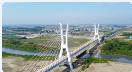
濁幹線與北幹線串接工程 115.3 竣工
