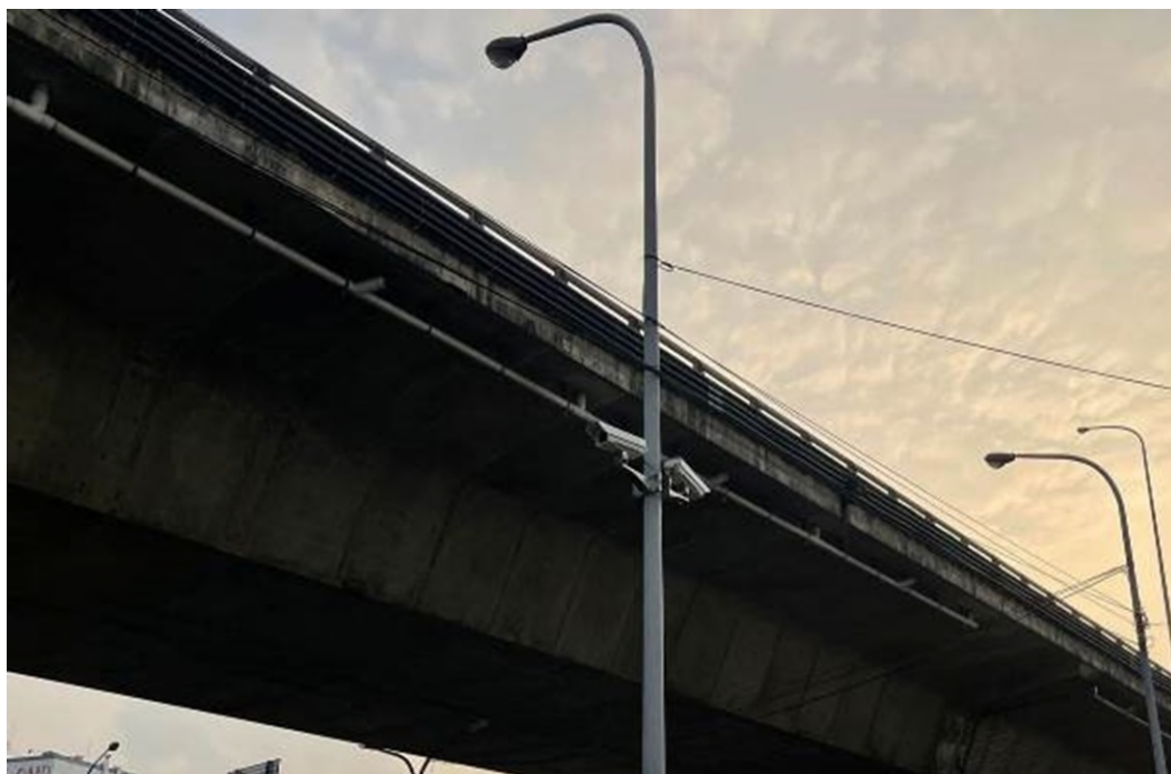
非法棄置圍籬：於主要交通幹道或廢棄物棄置熱區建置 IoT 監測設施，結合多模態 AI 分析系統進行大數據分析
