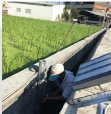
安裝燈架基座
