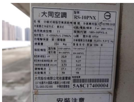
空調設備現況照片-20(11F 餐廳箱型機大同)
