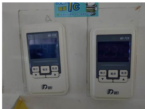
空調設備現況照片-16(FCU 控制器採用自動變速的溫控器)
