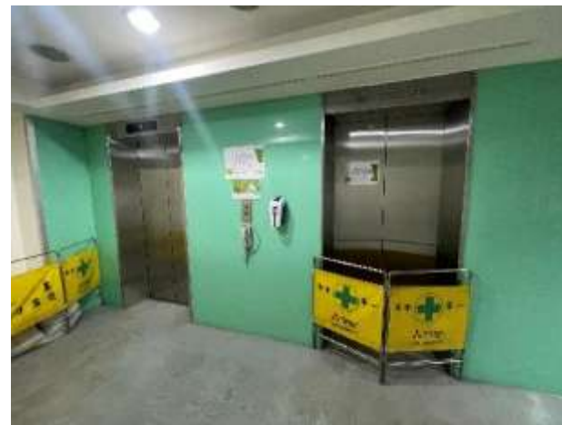
分段更新 (左為更新完成開放使用電梯，右為施工中電梯)
