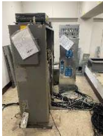
更換電梯控制系統
