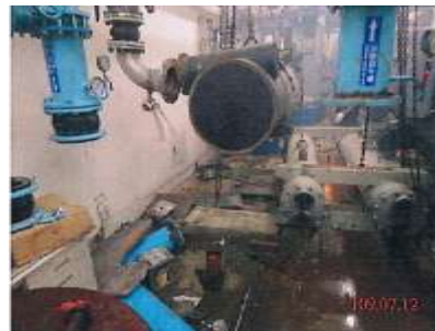
← 拆除舊有冰機及管路
