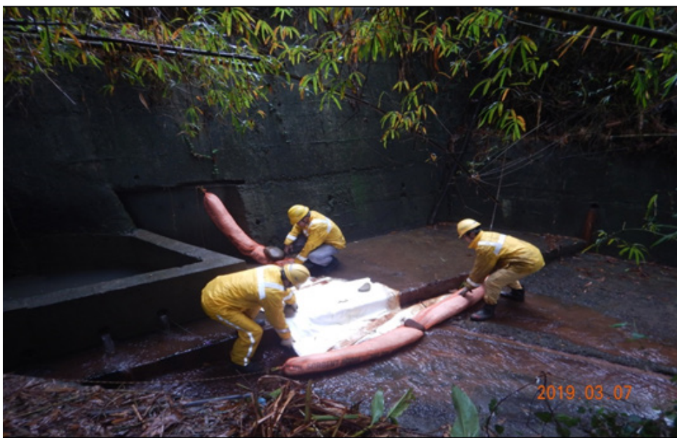
▲ 現場人員進行污染源下游緊急應變設施設置及更換
