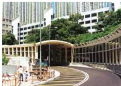
相比之下，現有道路的噪音問題更為棘手。香港共約有600條道路的交通噪音超過70 dB(A)，其中約40個路段可循工務計畫設置隔音屏障。解決其他現有道路噪音問題的方法則需另作考慮，方案包括：交通管制及減少使用車輛。經過多番努力，現時約有90%的新建住宅樓宇的交通噪音已低於70 dB(A) L<sub>10</sub>(1小時)。
