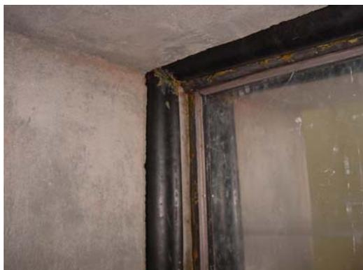
圖 5.2-35 隔音構件安裝實物圖
