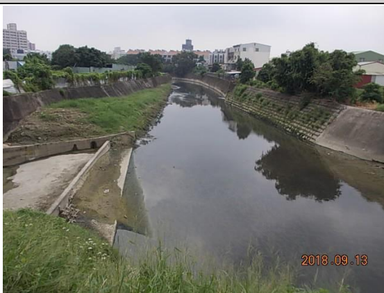
鹽行堤防 17 號水門〈23°02'34.0"N 120°13'43.0"E〉
