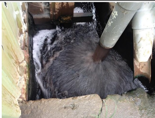
印染整理業_1 〈臺南市永康區鹽洲里洲尾街 41 巷 10 號〉
