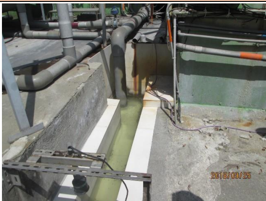
農業環境衛生用業製造業_1 〈臺中市大肚區中和里南榮路 101 號〉
