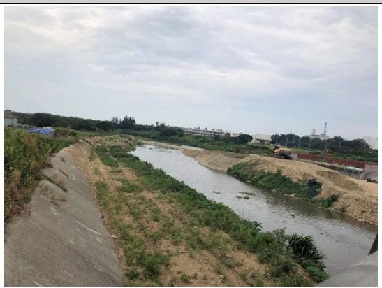
許厝港一號橋 <25°04'14.0"N 121°10'39.0"E>
