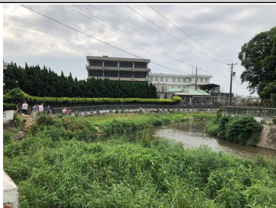
平鎮一號橋 <24°55'08.0"N 121°11'41.0"E>
