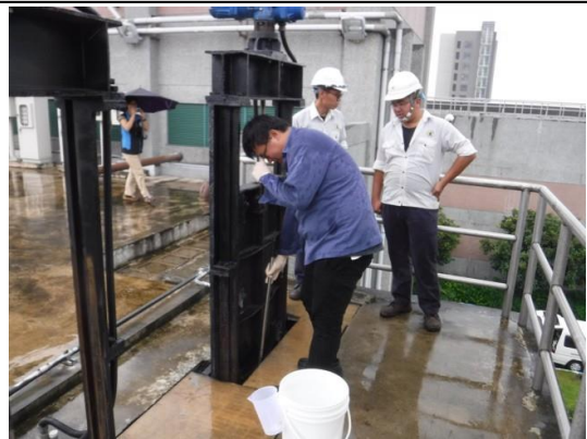
污水處理業_2-製程_1〈臺中市后里區后科路三段 2 號〉
