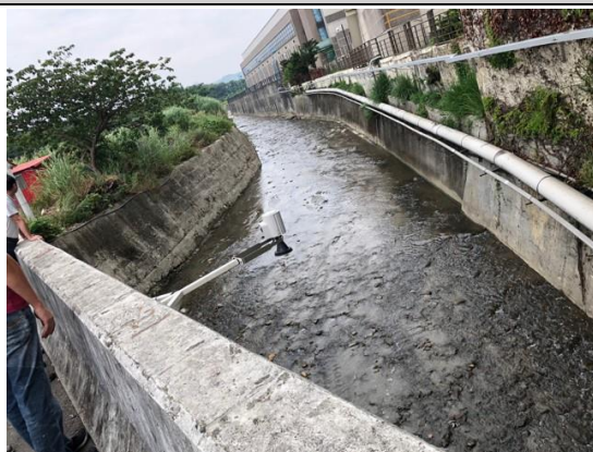
大坑缺橋 <24°54'08.0"N 121°11'32.0"E>
