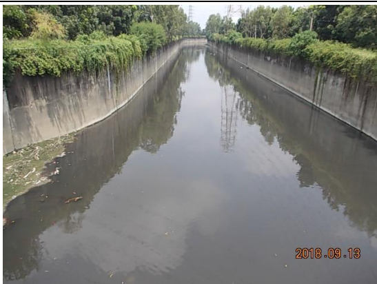
大洲排水線〈23°01'16.2"N 120°16'56.1"E〉
