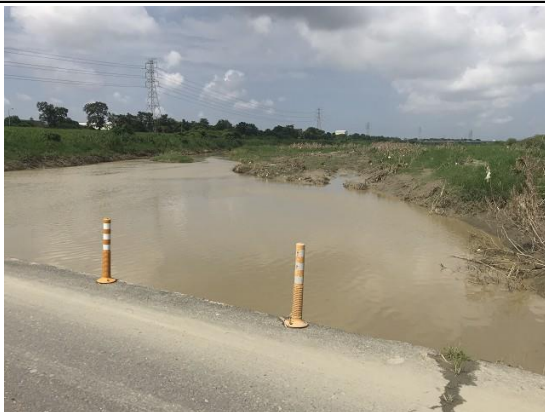
鹽水溪便橋 < 23°03'32.7"N 120°15'48.0"E >
