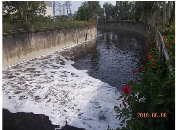
大洲排水線 < 23°01'16.2"N 120°16'56.1"E >
