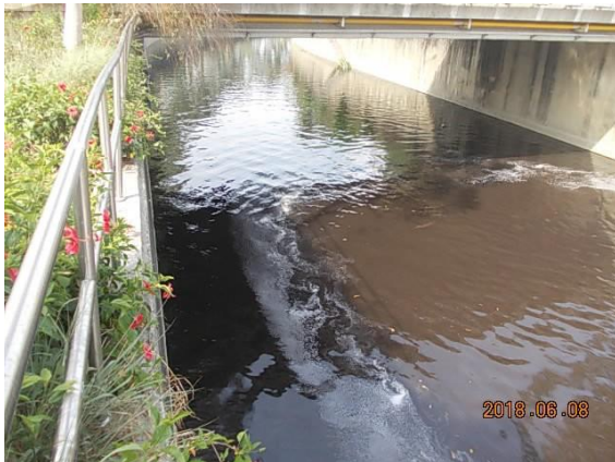
大洲排水線 < 23°01'16.2"N 120°16'56.1"E >
