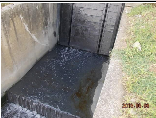
鹽行堤防 14 號水門 <23°01'54.0"N 120°13'21.0"E>
