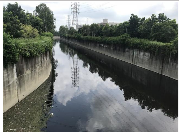
大洲排水線 < 23°01'16.2"N 120°16'56.1"E >
