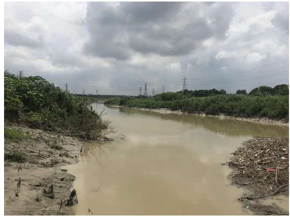
鹽水溪便橋 < 23°03'32.7"N 120°15'48.0"E >
