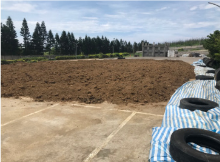
針對中油地面貯槽疏漏污染，環保署已啟動緊急應變機制
