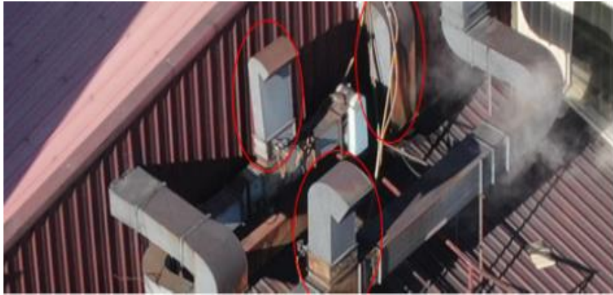
廠房屋頂 3 處繞流排放管道
