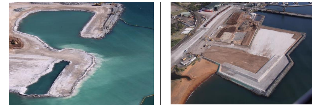
圖 5.1.2-11 澳洲肯布拉港外港 1A 期填築中及填築完成情形
