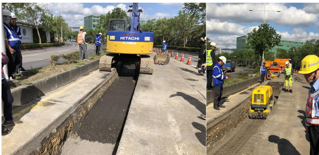
圖 4.3.1-1 臺北市試辦「冷拌再生瀝青混凝土」進行 CLSM 管溝回填
