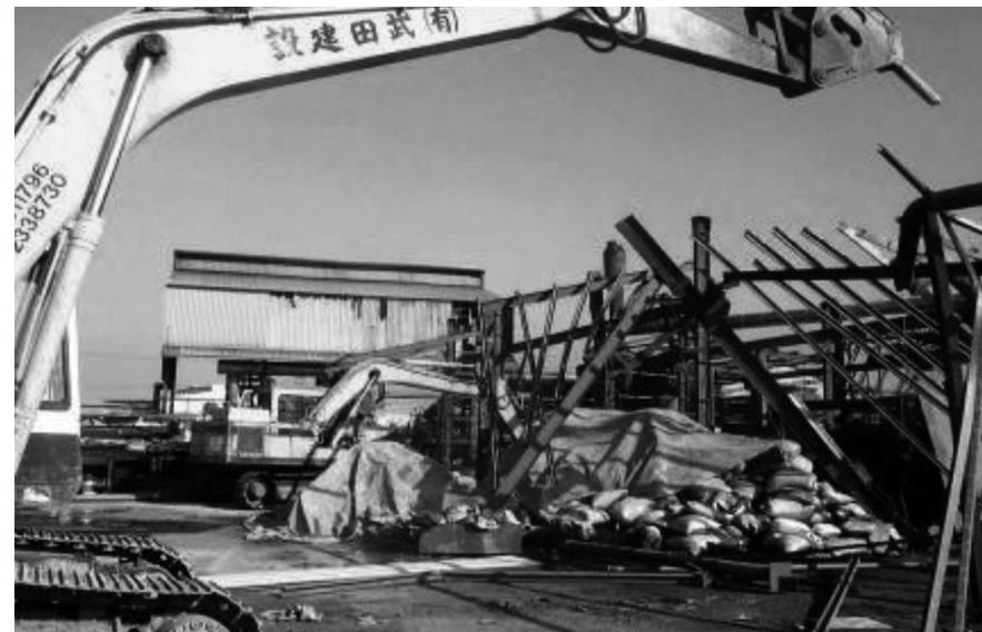
二仁溪違法熔煉廠執行強制拆除情形。
