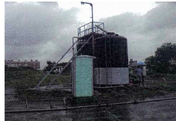
RCA整治廠址，以ERD注入系統。
