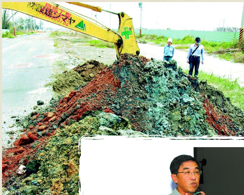
舊台鹼安順廠污染案，在廠外二等九號道路預定地下，挖出五顏六色的污染土壤。
