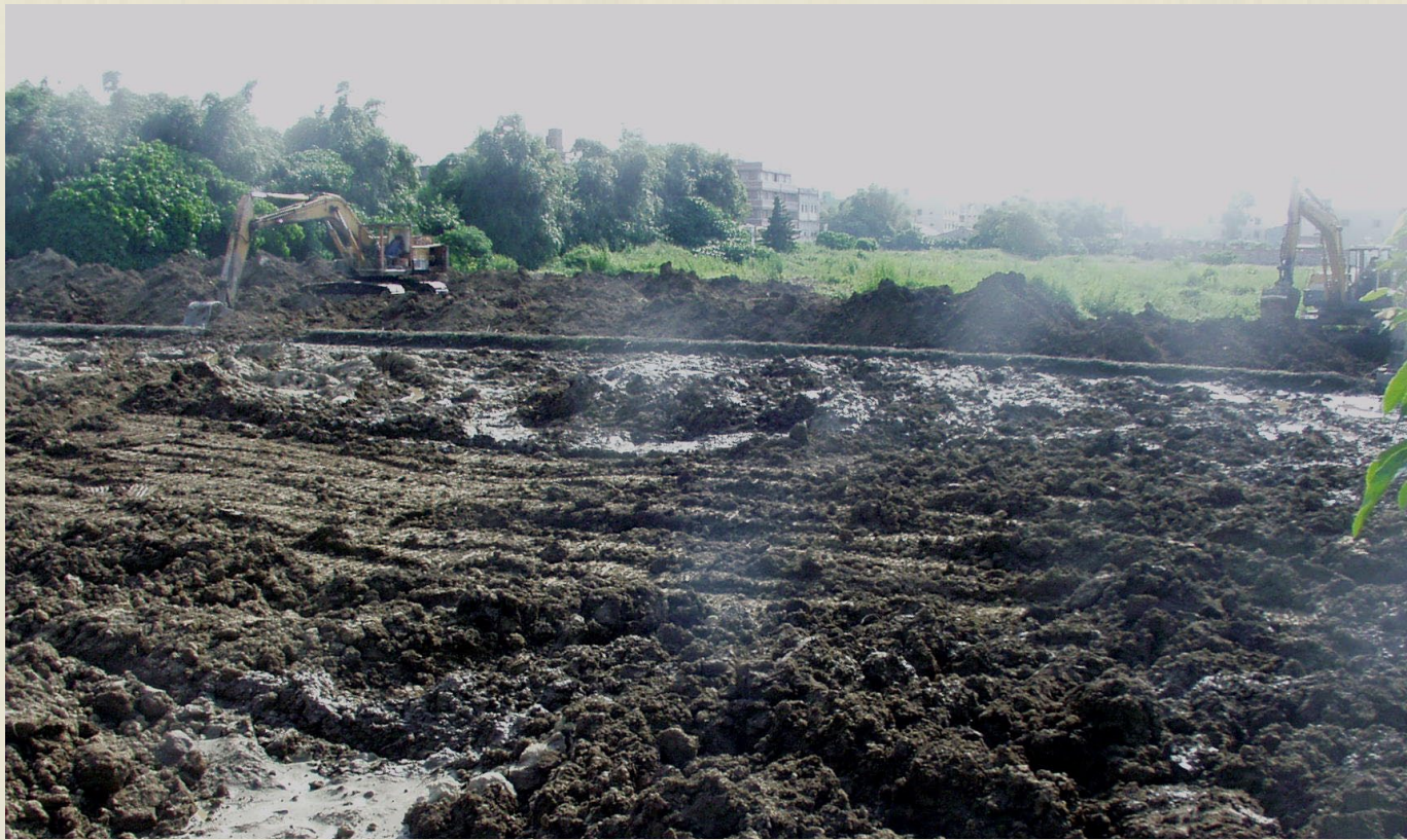
位於和美鎮的低度鎘污染農地已展開整治，採取翻土稀釋法。
