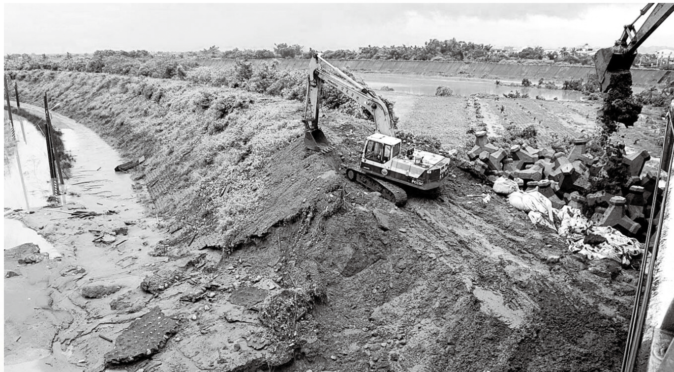
急水溪河岸整治工程。
