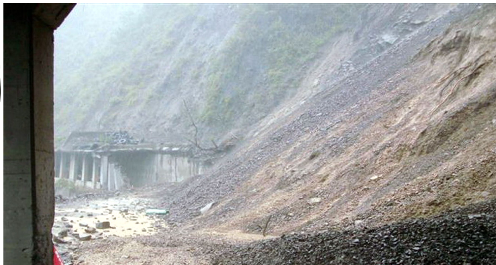
因為莫拉克颱風受災嚴重的南投縣信義鄉東埔村哈比蘭明隧道，因雨再出現坍方，交通中斷，東埔溫泉區約有居民900人及60名遊客被困。
