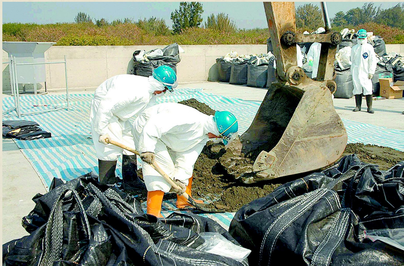
台鹼安順廠污染土壤已展開移除、封裝工程，現場同時進行採樣，全程派員監督、記錄存證。
