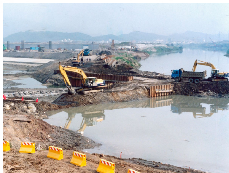
淡水河整治工程施工情形。
