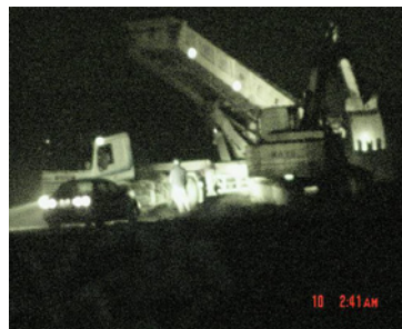
棄土場內夜間非法堆置、掩埋
