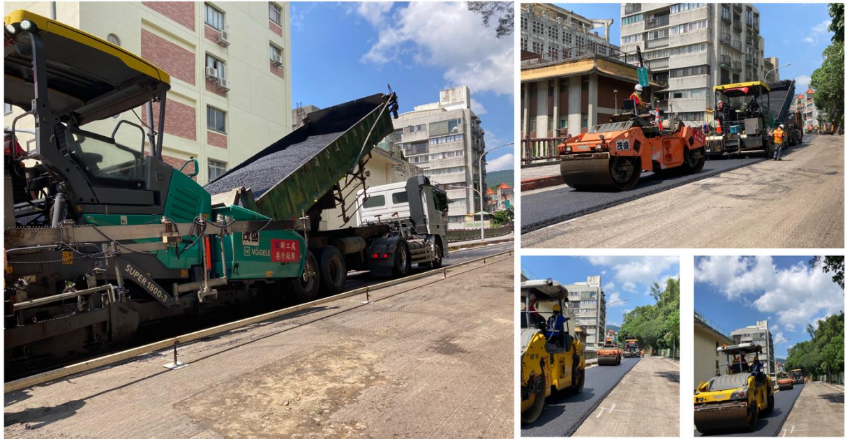
圖7.台北市新工處在內湖路二段179巷鋪築溫拌橡膠瀝青路面照片
