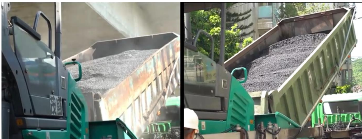
圖8. 熱拌(左)與溫拌(右)橡膠瀝青混凝土卸料煙霧量比對照片
