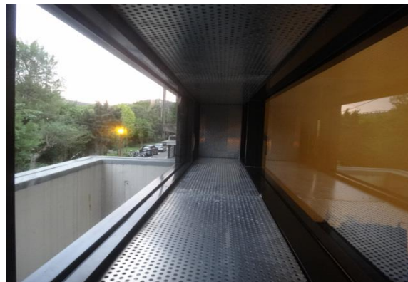
通風管道之壁面設置吸音材
