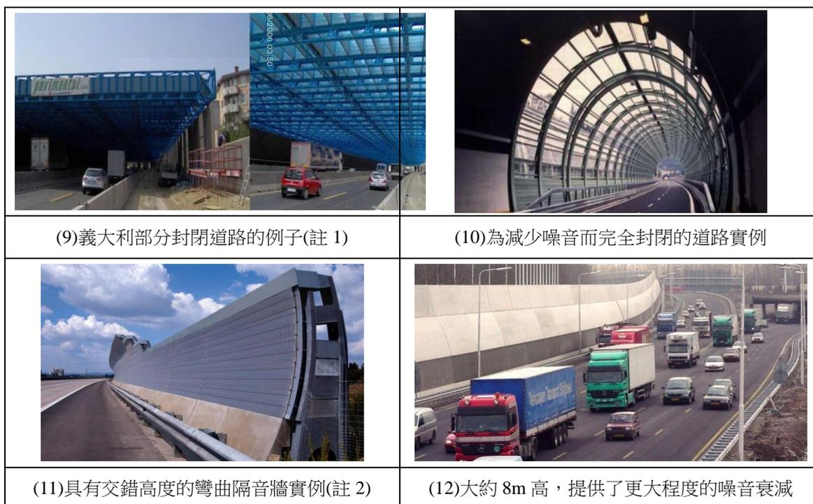
圖 5.2-7 國外高速公路之各種型式隔音牆實例照片<sup>[1]</sup> (2/2)
