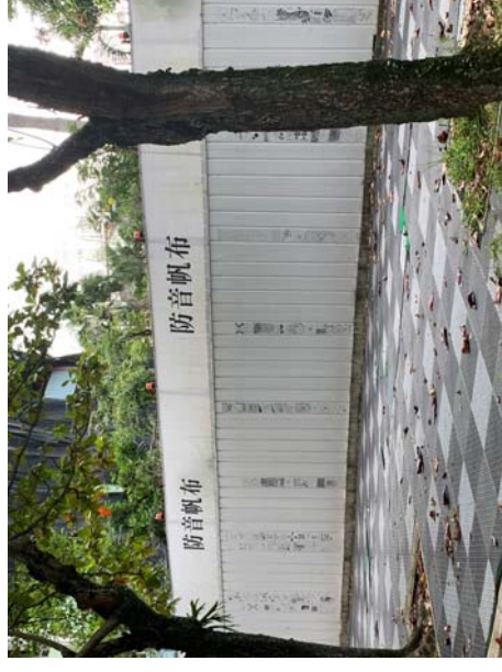
圖 31 常見錯誤的隔音毯材料（防音帆布）
