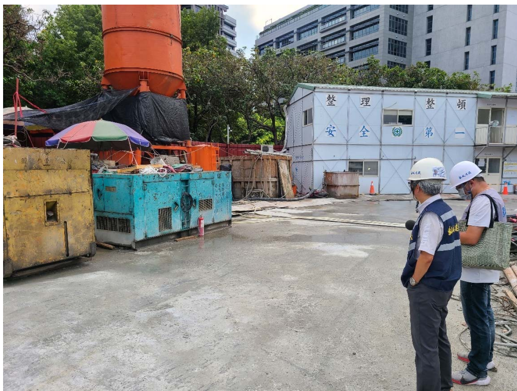
圖 4.3-1 低噪音型發電機
