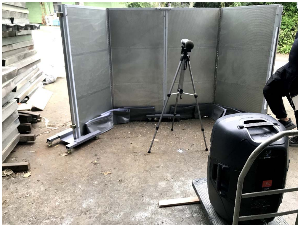
圖4.4-6 移動式防音隔屏135°正面
