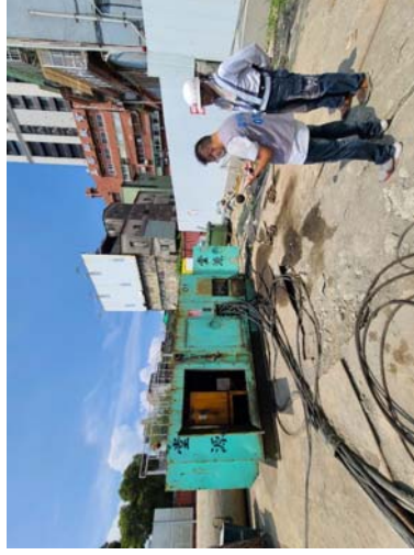
圖 33 常見錯誤的操作行為（發電機未閉合）
