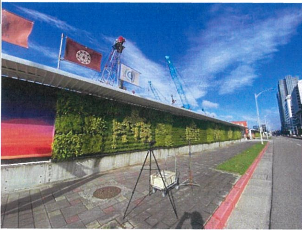
測量項目：營建工程噪音 測量地點：工區圍籬外側 1 公尺處 測量日期：109 年 11 月 06 日
