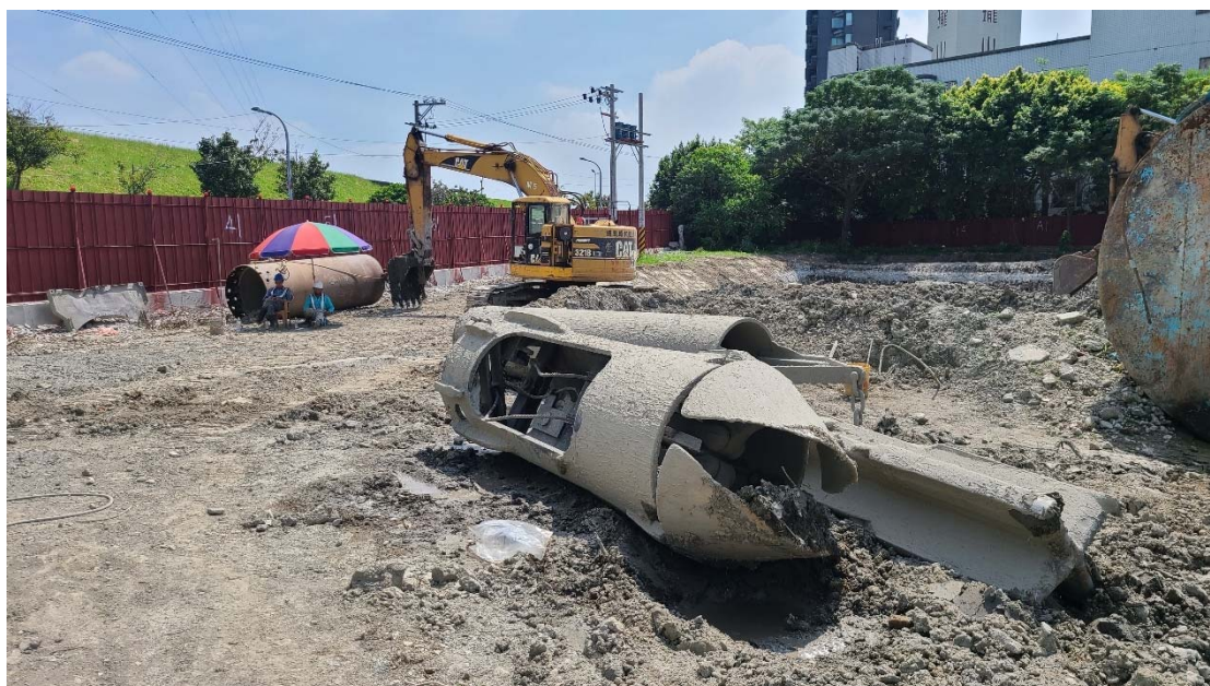
圖 4.2-2 靜壓挖掘式挖掘頭
