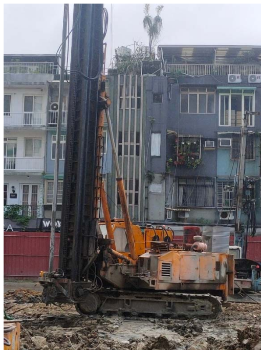
圖 4.2-5 高壓噴射灌漿工法
