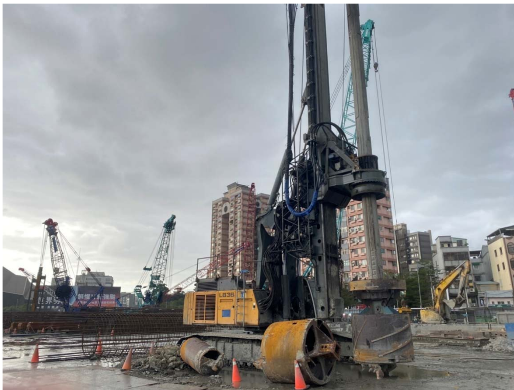
圖 3.2-2 低噪音型鑽鑿機
