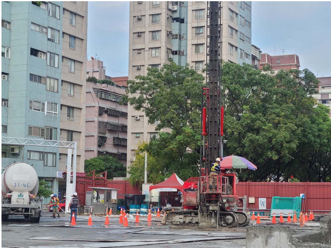
圖 4.2-4 靜壓式灌注方式
