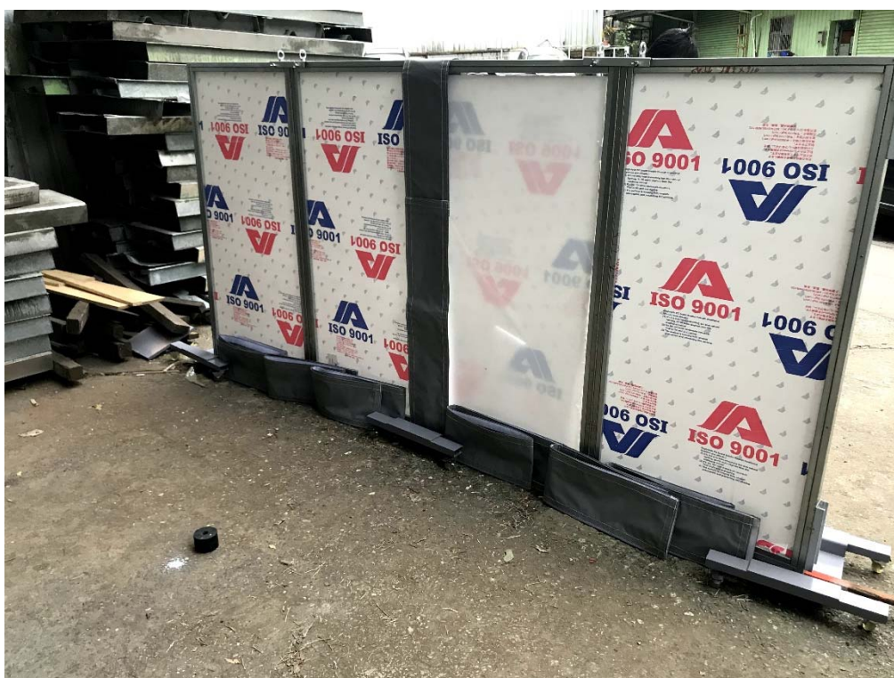
圖 3.2-10 新式移動式防音屏
