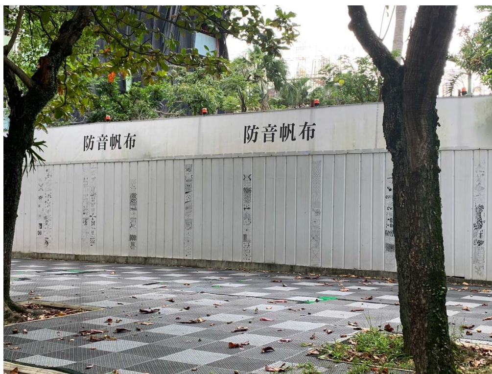
圖 3.2-5 常見錯誤的隔音毯材料(防音帆布太薄)
