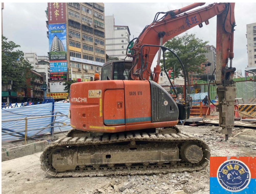
圖 4.2-7 低噪音機具(破碎機)
