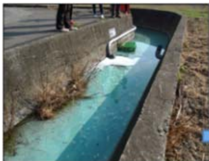
▲ 工業廢水排入渠道
