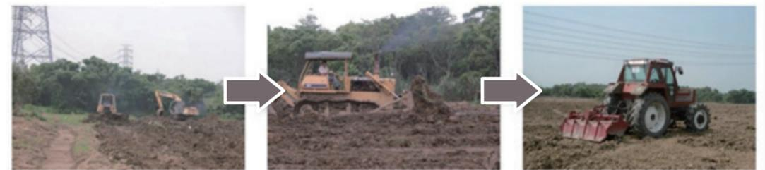
步驟 1: 挖起高污染土壤 步驟 2: 將高污染土壤移至低污染區 步驟 3: 完成高污染區土壤一至低污染區作業
