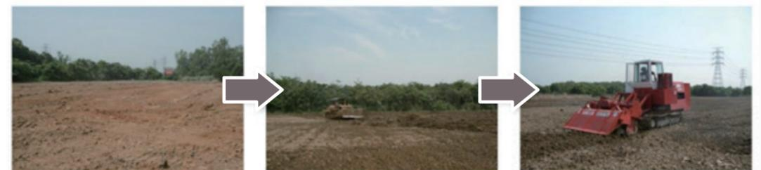
步驟 4: 進行來回地翻轉稀釋 - 水平稀釋 步驟 5: 將充分混和之土壤推回原處 步驟 6: 進行來回地翻轉稀釋 - 垂直稀釋
