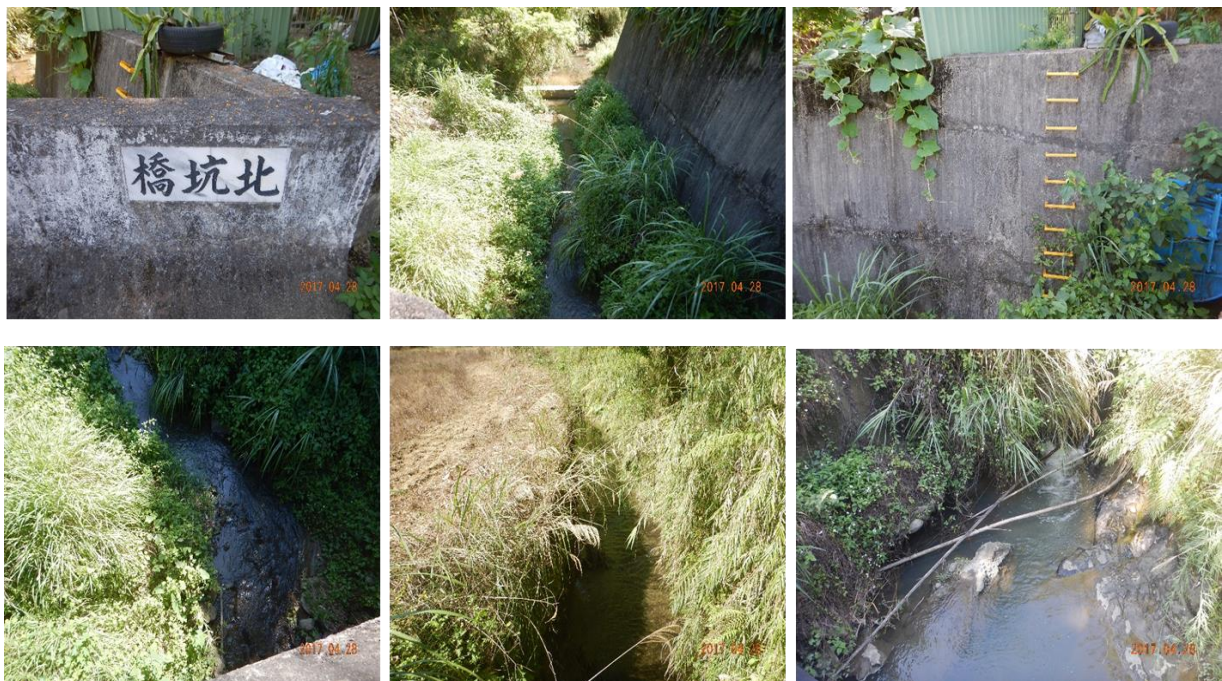
圖 4- 1、客雅溪源頭的北坑橋
