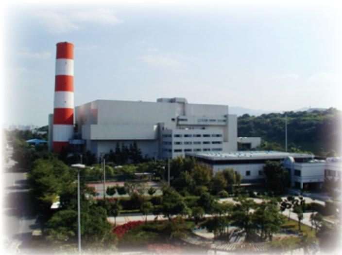
廠為全國及臺北市第一座現代化大型垃圾焚化廠，設置有完善之進料、貯存、焚化、熱能回收、發電及污染防制設備。受限於飛機航道高度管制，煙囪高度僅 74 公尺，並依「航空障礙物標誌與障礙燈設置規範」規定將煙囪外觀採紅白相間塗漆。
