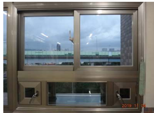
圖 3. 完成之主動式降噪自然通風隔音窗實物
