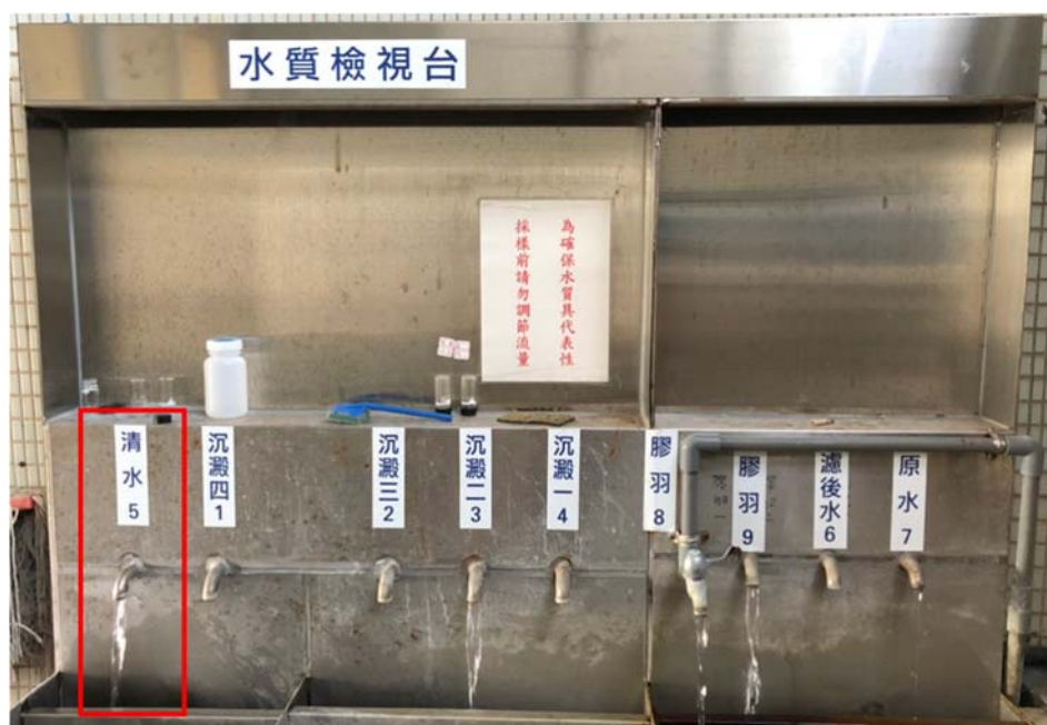
圖 18 餘氯電化學分析技術平台實際水樣測試水源
