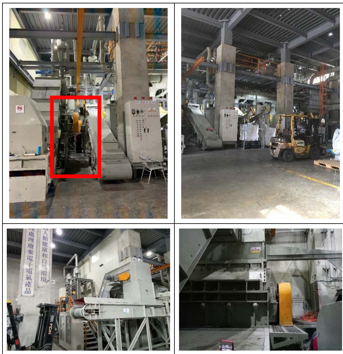
圖 4.5-3 甲處廠主要振動源機台設備
