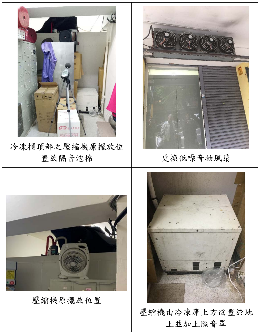
圖 4.5-12 現場量測照片
