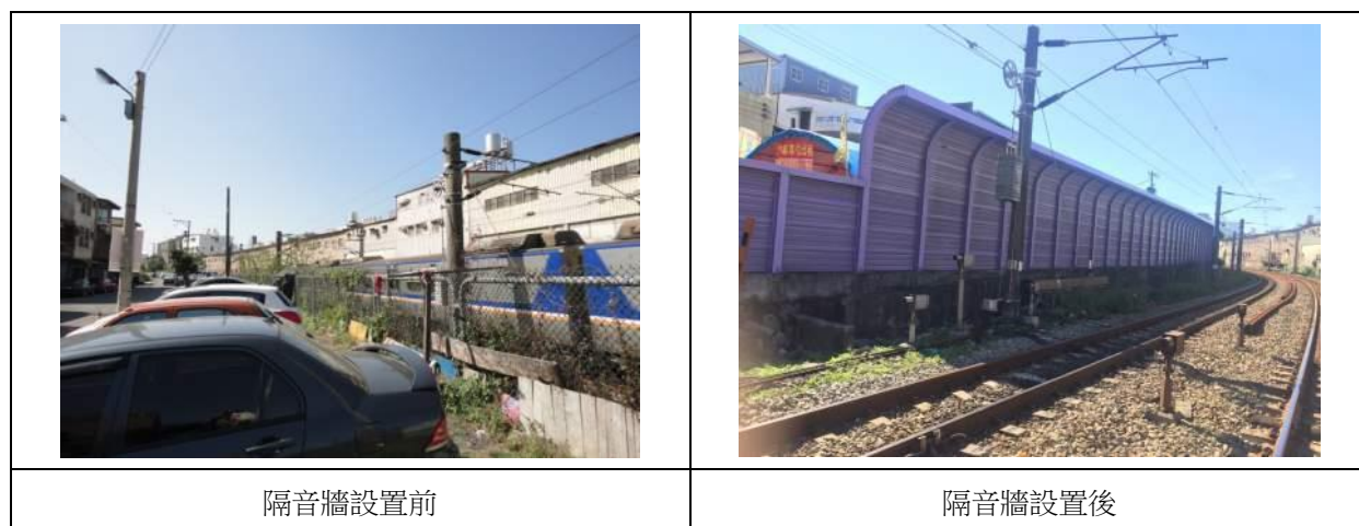
圖 5.2-5 新竹新豐改善計畫設置 4m 高倒 L 型金屬吸音板隔音牆照片
