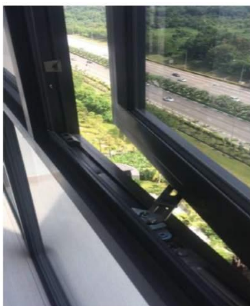
圖 4.1-18 新加坡住宅窗口上的窗口限制器 [14]
