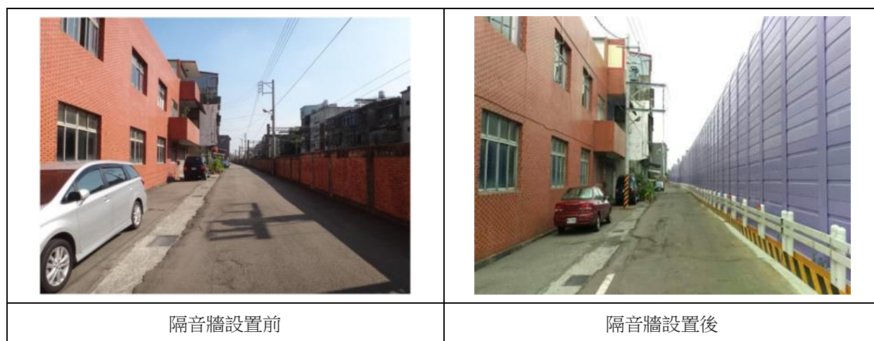
圖 5.2-4 新竹湖口改善計畫設置 6m 高倒 L 型金屬吸音板隔音牆照片
