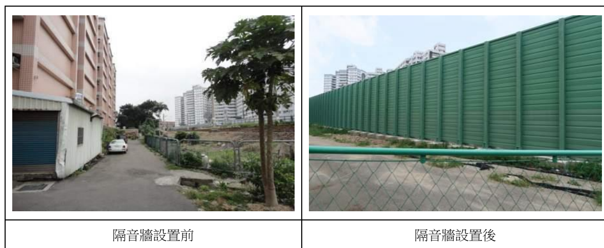
圖 5.2-2 桃園平鎮改善計畫設置 6m 高金屬吸音板隔音牆照片
