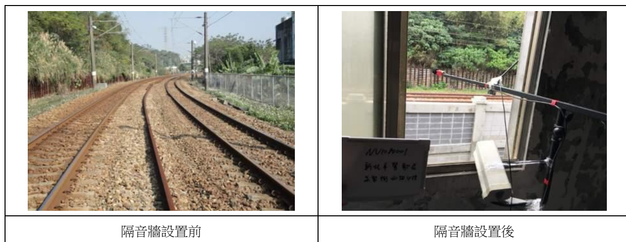
圖 5.2-1 新北鶯歌改善計畫設置 3m 高空心磚隔音牆照片
