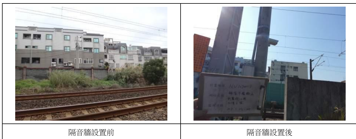
圖 5.2-3 桃園楊梅改善計畫設置 4m 高金屬吸音板隔音牆照片
