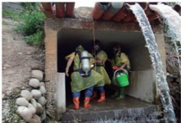
▶ 稽查人員身著青蛙裝空氣呼吸器深入下水道
