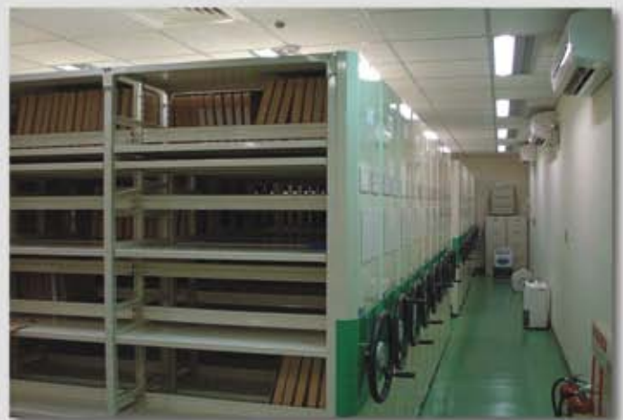
進行檔案室裝修施工（96年）
