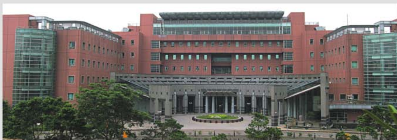
現址 - 本署中壢辦公園區目前外觀 (101 年拍攝)
