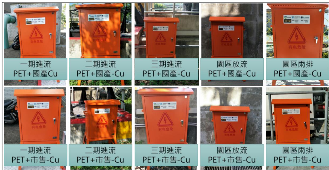
圖 16 固定式水質感測系統裝設照片-竹科園區
