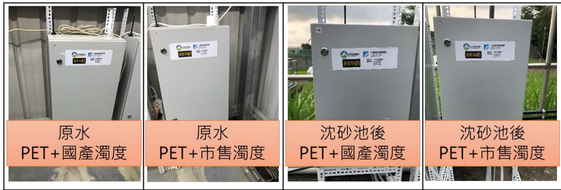
圖 12 固定式水質感測系統裝設照片-頭前溪原水及 30,000 噸沈砂池後
