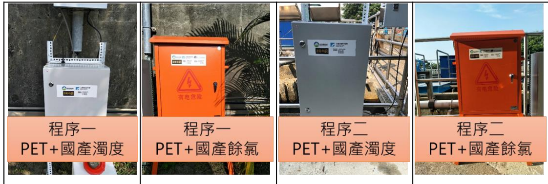
圖 13 固定式水質感測系統裝設照片-新竹市第一淨水廠
