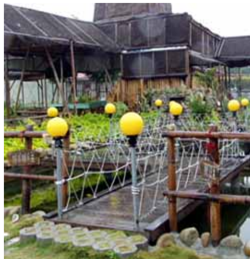
以廢棄水管及混凝土拼成的曲橋(寶之林)
