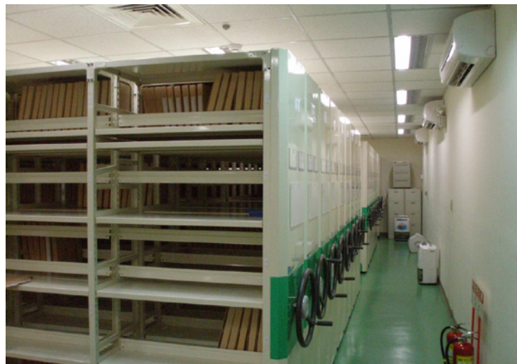
進行檔案室裝修施工（96 年）
