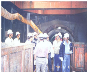
參觀台北市下水道工程
