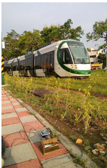
圖 4.3.2-36 測量現況(高雄輕軌-夢時代)
