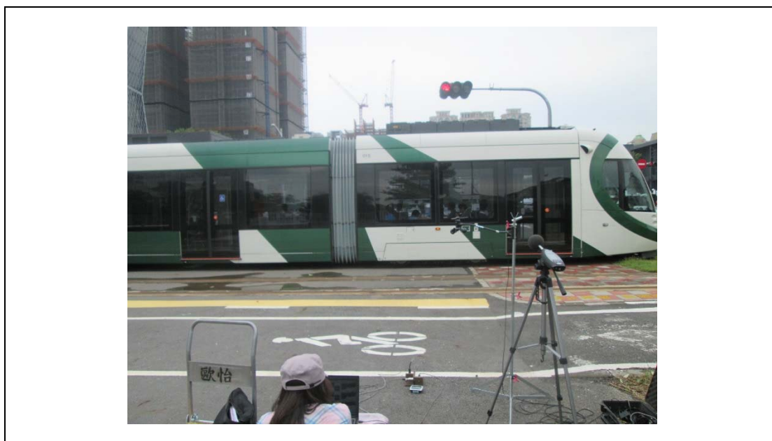
圖 4.3.2-32 測量現況(高雄輕軌-中鋼)
