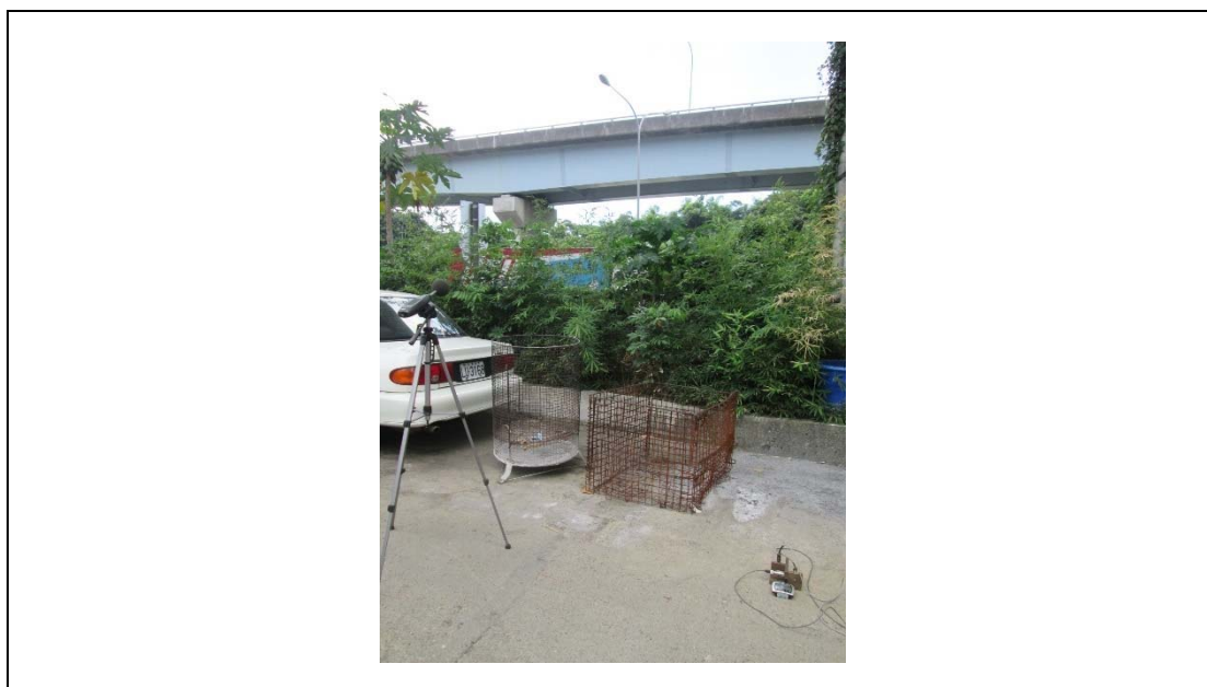
圖 4.3.2-8 測量現況(國道 3 號-內湖無極宮)
